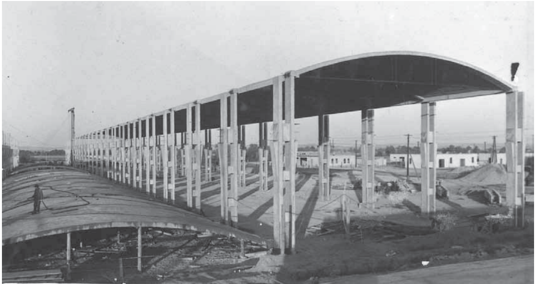
Source Zdroj: Foundation for Modern Industrial Architecture – IPARTERV Photo Archive / (Modern) (Ipari) Építészeti Alapítvány – IPARTERV Fotóarchívum, No. 6171
