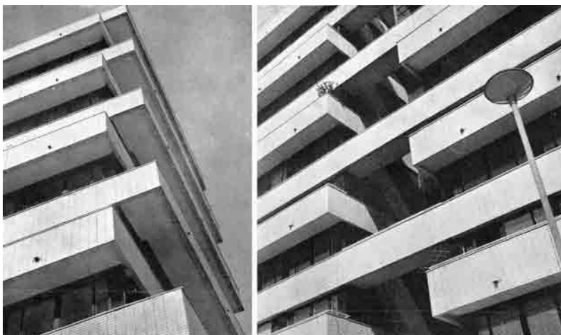
Source Zdroj: Vuković, S.: Stambena zgrada »B« u bloku 21 na Novom Beogradu, Čovjek i prostor (Zagreb) XIV, 1967, 176. pp. 1 – 4, illustrations p. 3, 4
