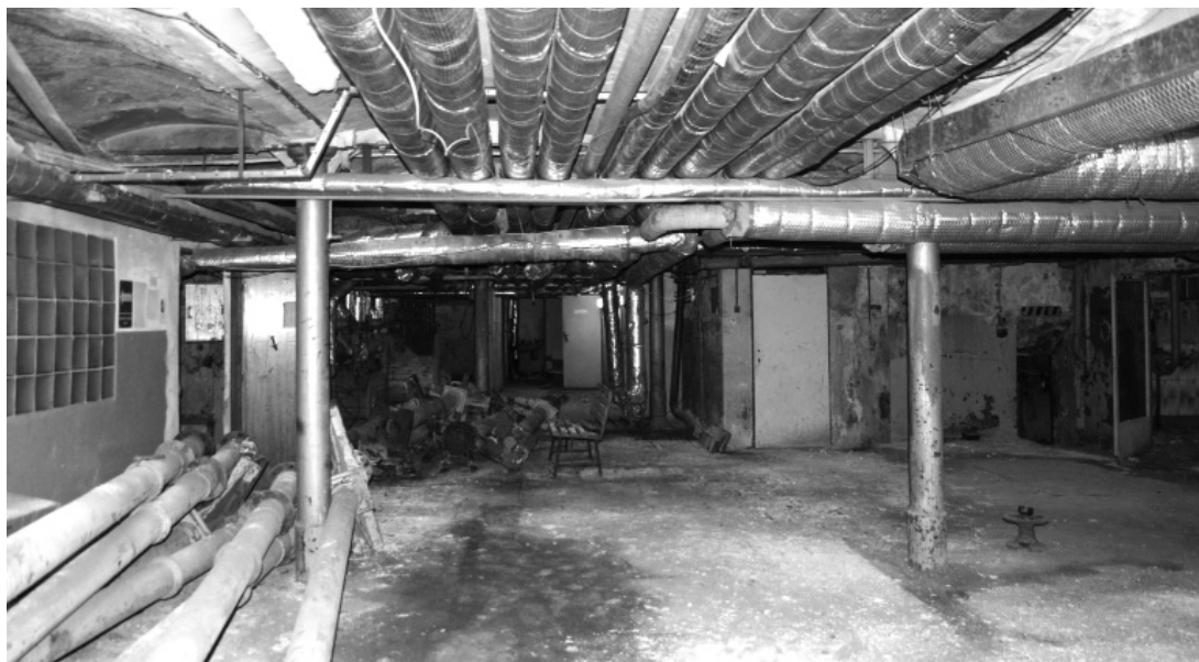
Císařské lázně, Rašelinový pavilón, manipulační hala v přízemí, Karlovy Vary
