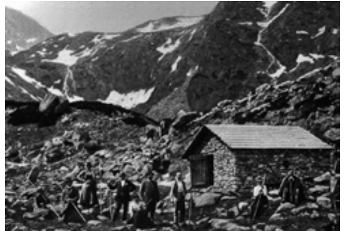
SHELTER FOR LABOURERS AT MALÁ STUDENÁ DOLINA ROBOTNÍCKY PRÍSTREŠOK V MALEJ STUDENEJ DOLINE Source Zdroj: Bohuš, I., Tatranské chaty, 2011
