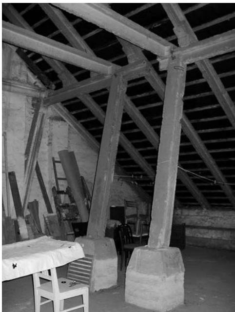
MONTOVANÝ ŽELEZOBETONOVÝ KROV V DOMĚ NA ULICI BOHUSLAVA MARTINŮ, PORUBA 2. OBVOD
